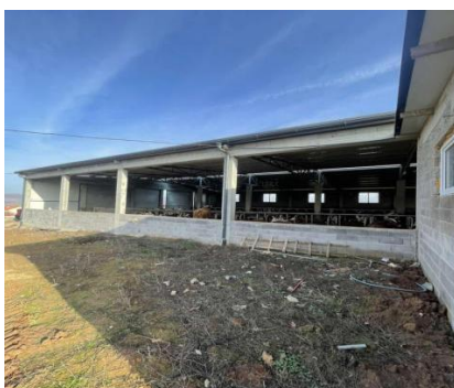
Foto 11, 12, 13: (Foto: Muhamet Shala, 2025, Kosovë). Fermë me hapje anësore dhe ventilim natyral (përmasat: 29 m gjatësi \times 20.5 m gjerësi \times 6 m lartësi).
