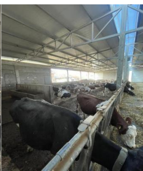
Foto 11, 12, 13: (Foto: Muhamet Shala, 2025, Kosovë). Fermë me hapje anësore dhe ventilim natyral (përmasat: 29 m gjatësi \times 20.5 m gjerësi \times 6 m lartësi).
